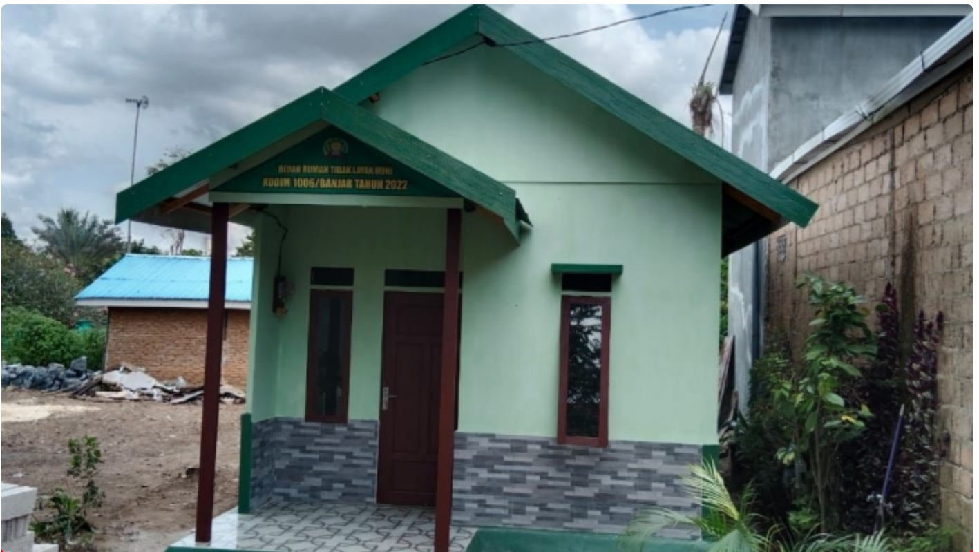
Dulu Reot Dan Tak Layak Ditempati " Esok Rumah Nursiah Berdiri Tegak Minimalis Diserahkan
